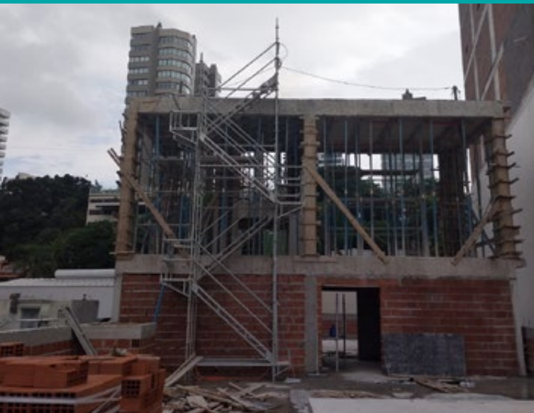
Concretagem última laje
