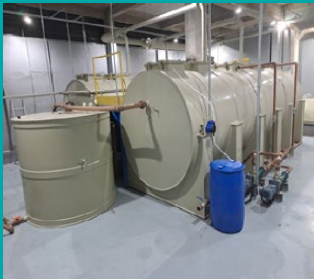
Instalação de nova estação de tratamento de efluentes no Prédio das Engenharias
